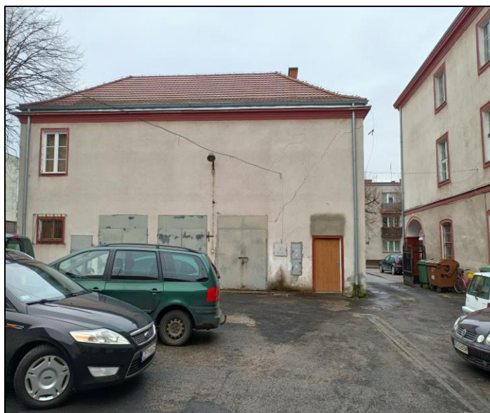
Budynek B - gospodarczo – garażowy z archiwum na piętrze
