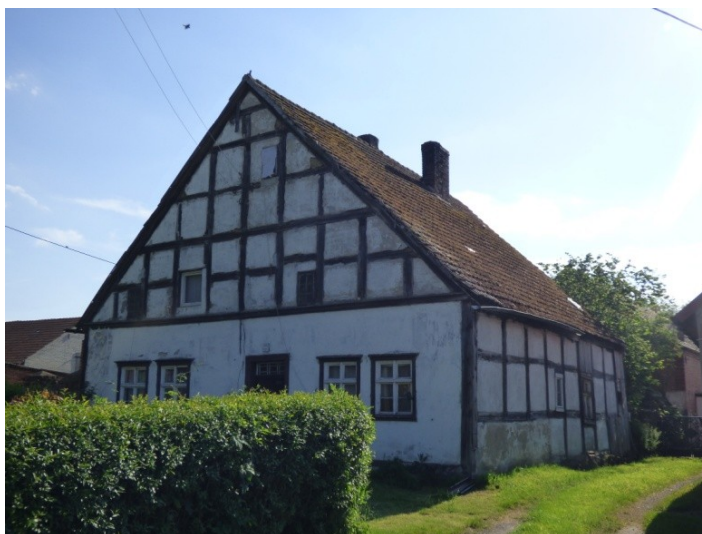
Fot. 23. Dom mieszkalny w Letninie datowany na lata 1790-1810-przykład tzw. chaty pyrzyckiej
