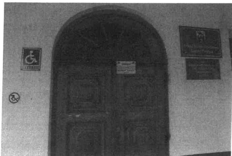
Zdjęcie Nr – 2 wejście boczne do Urzędu Miejskiego od ul. Kilińskiego
