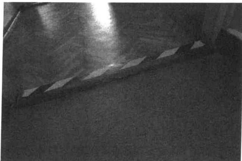
Zdjęcie Nr 4 – próg na korytarzu w budynku Urzędu
