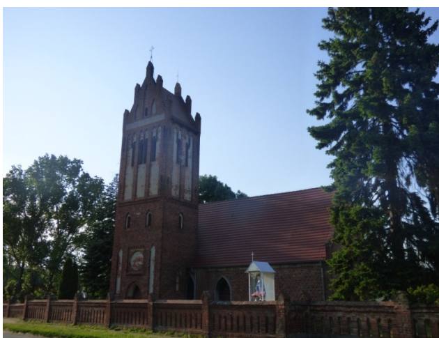
Fot. 37. Kościół w Mechowie Źródło: fotografia własna
