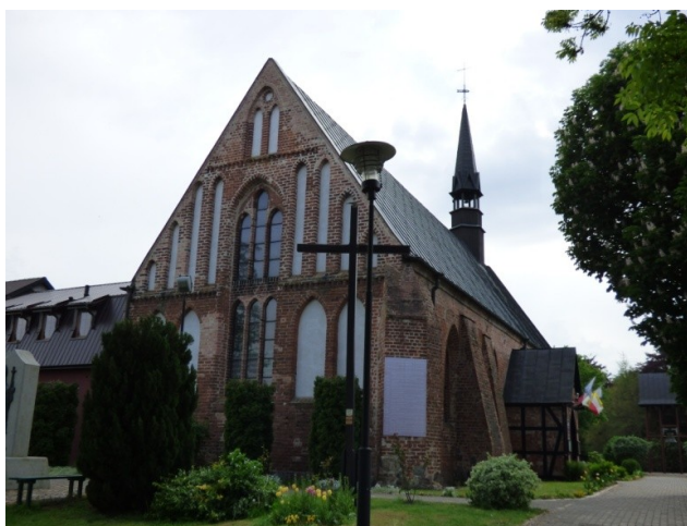
Fot. 29. Kościół w Pyrzycach przy ul. Staromiejskiej obecnie Źródło: fotografia własna
